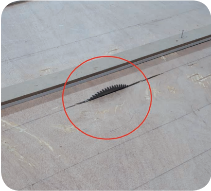
목재가공용 동근톱 날접촉방호덮개 미설치
