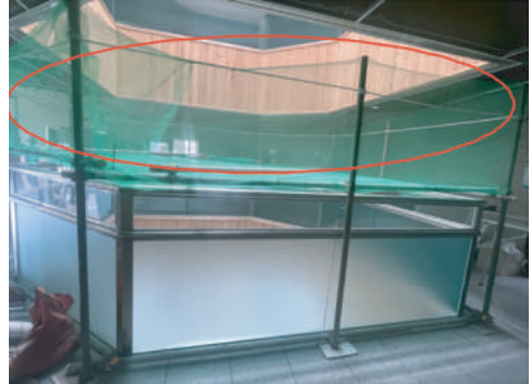
중정에 추락방호망 설치
