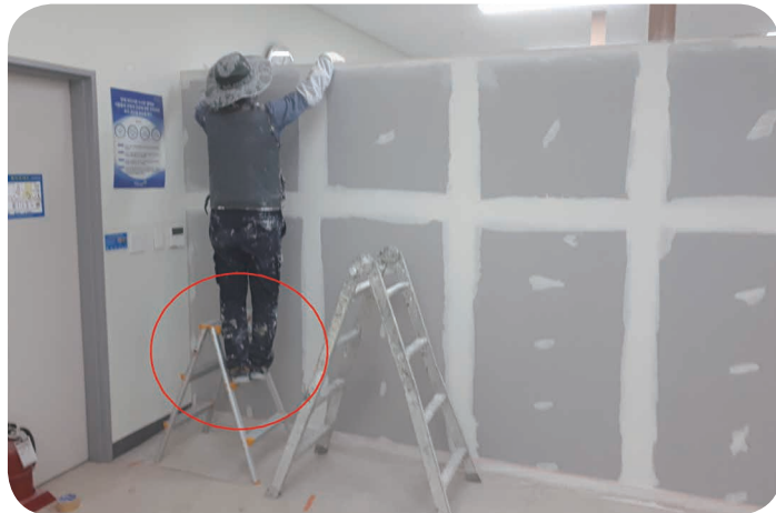
이동식 사다리 전도 위험, 안전모 미착용 » 이동식 사다리 2인 1조 작업, 안전모 착용 지도
