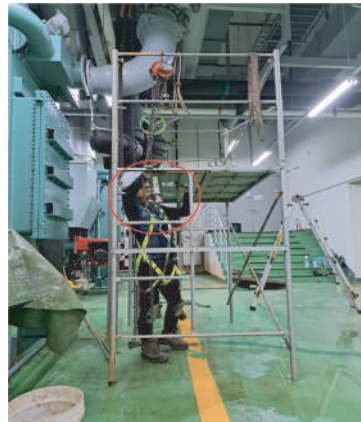
작업발판 틈이 발생하지 않도록 작업발판 추가 설치
